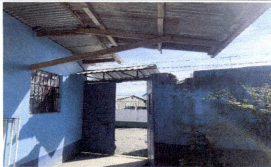
Foto 11: Pared del exterior con daños severos.
