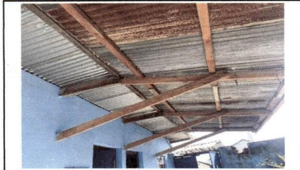
Foto 3: Vigas de madera en mal estado.
