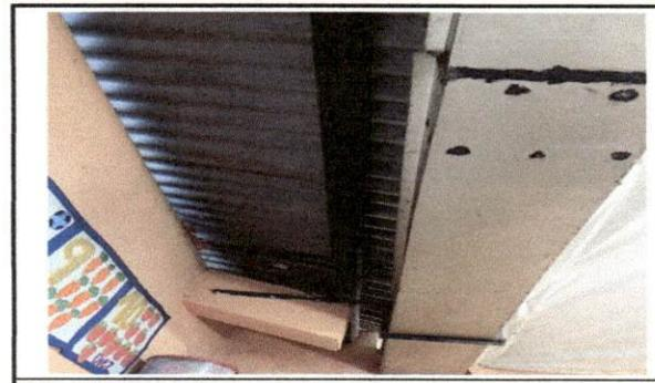
Foto 6: Lámina interior con filtraciones de agua.
