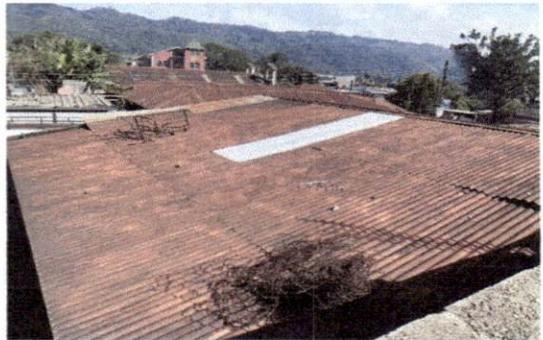
Foto 8: Láminas en mal estado y corridas.
