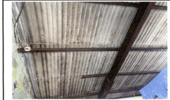
Foto 4: Láminas corroidas en el pasillo.
