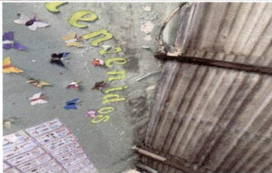
Foto 9: Lámina dañada por corrosión en el interior.
